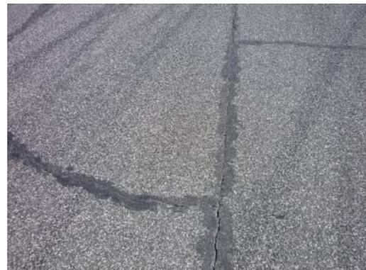
Figura 29: interventi di sigillatura a bitume
