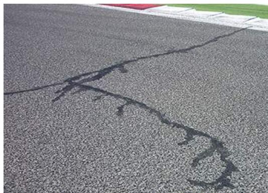
Figura 23: intervento di sigillatura a bitume
