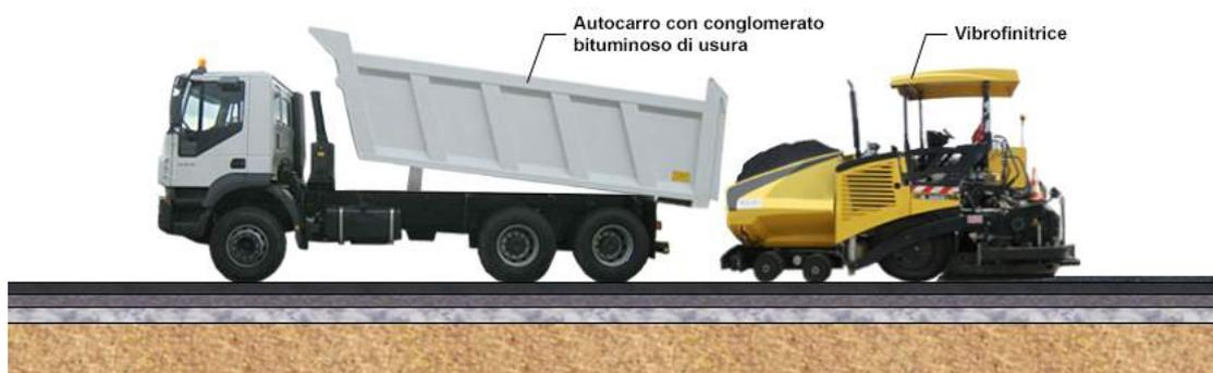
Figura 97: posa di 4 cm di tappeto d'usura con vibrofinitrice
